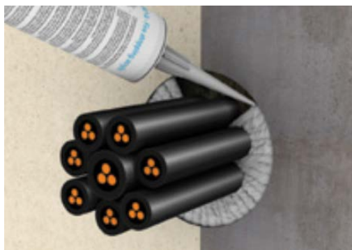
Primjena protupožarnog akrilata
